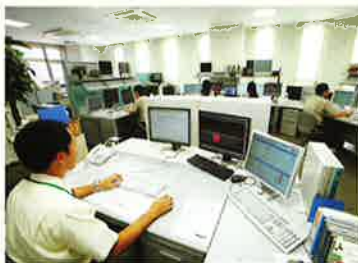
コントロールセンター
